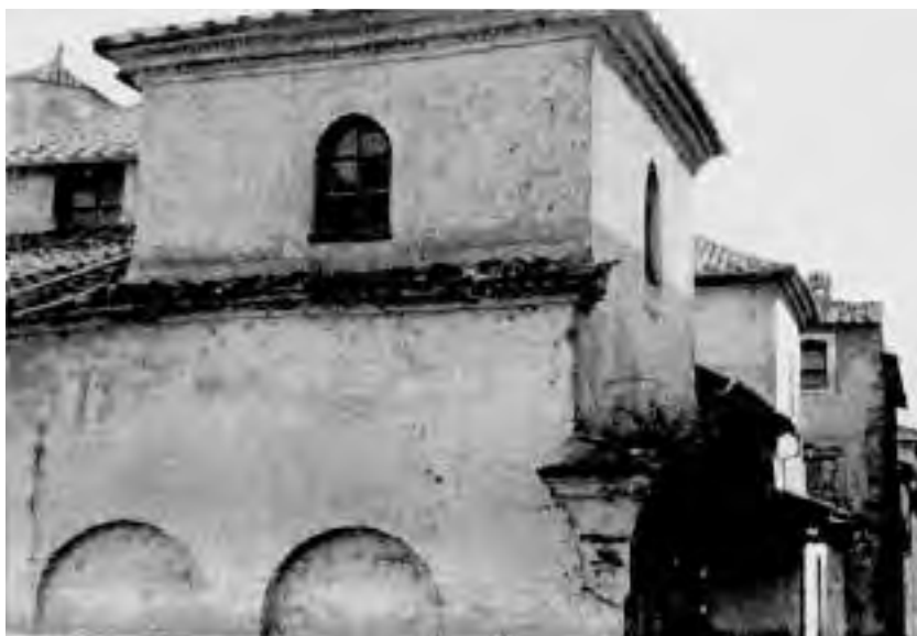
43. - Particolare della facciata Est.
