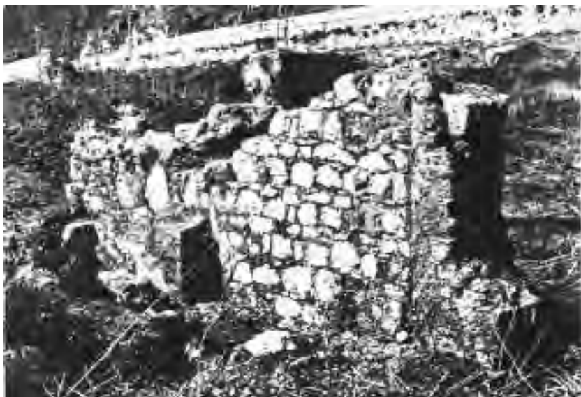
54. - 1963: retro della parete absidale sul lato destro ( da A. Pantoni ).
