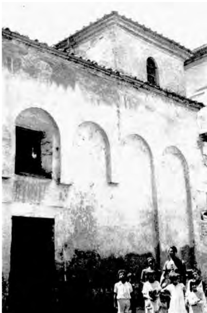
41. - Ingresso laterale (da T. Vizzaccaro).
